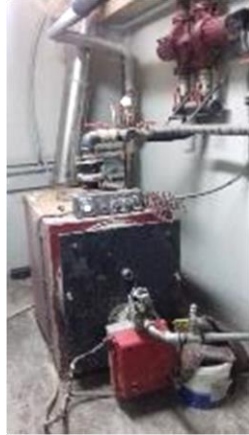
Φωτογραφία Λεβητοστασίου Α
