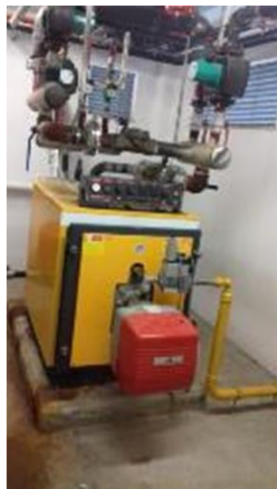
Φωτογραφία Λεβητοστασίου Α
