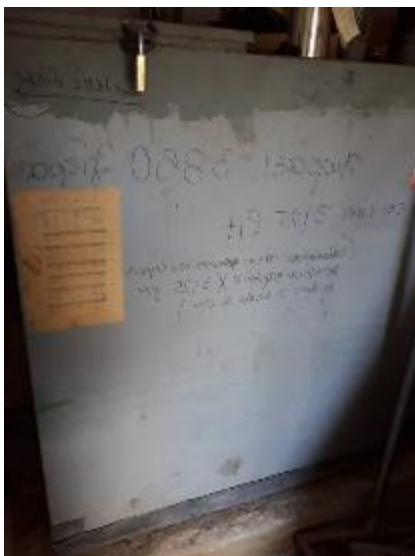
Φωτογραφία Δεξαμενής πετρελαίου
