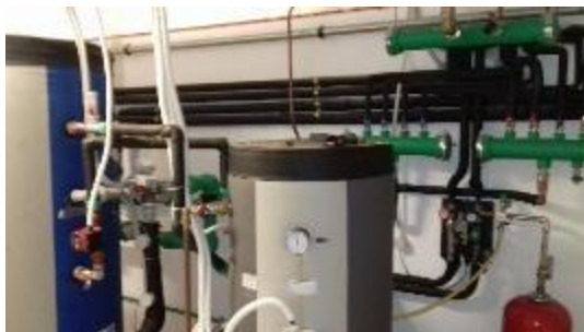
Φωτογραφία Λεβητοστασίου Α
