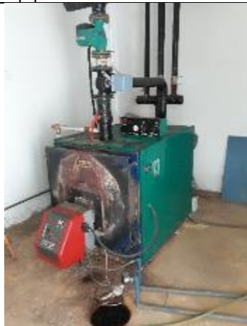
Φωτογραφία Λεβητοστασίου Α
