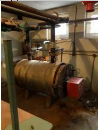
Φωτογραφία Λεβητοστασίου Α
