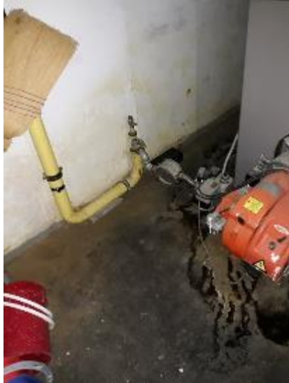
Φωτογραφία Λεβητοστασίου Α
