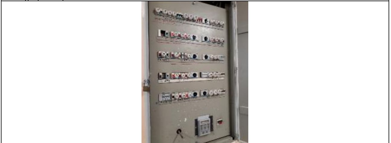
Φωτογραφία Λεβητοστασίου Α
